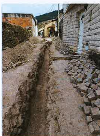
Remodelação de conduta – Ribalonga
