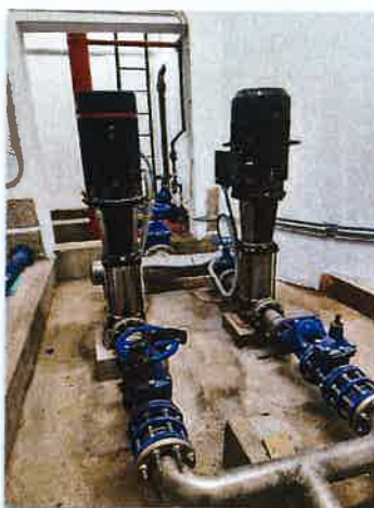
Remodelação Grupo de Bombagem – Res. Ferreiro
