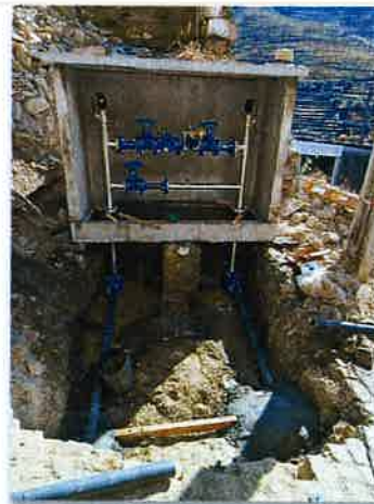
Instalação de válvulas redutoras de pressão
