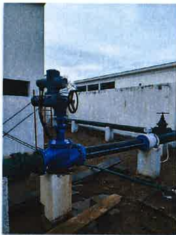
Reabilitação válvula motorizada - ETA
