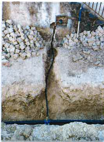
Remodelação de Ramais de Abastecimento
