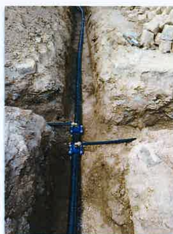
Remodelação de conduta – Ribalonga
