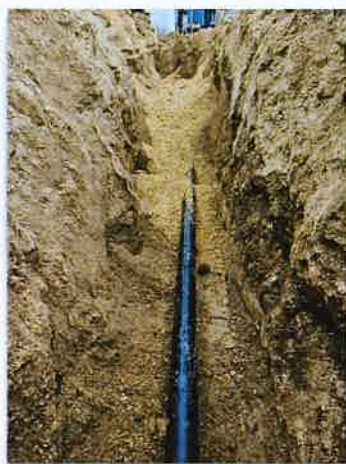
Remodelação de conduta – Penafria
