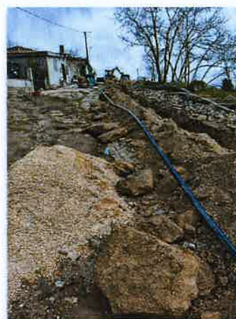
Remodelação de conduta – Penafria
