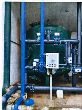
Reabilitação filtros pressurizados - ETA
